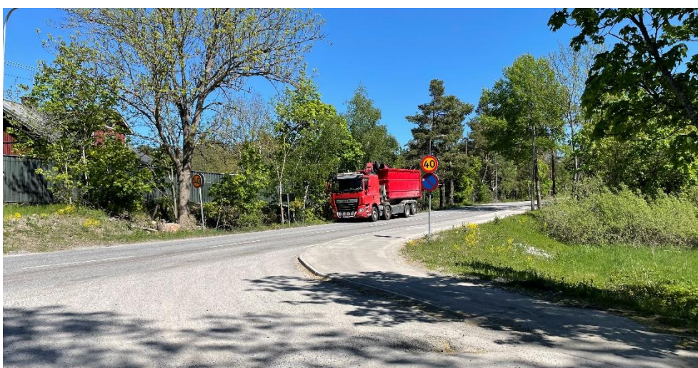
Figur 12 Separat gångbana som ligger mellan Erstaviksvägen och gångbron i figur 11.
