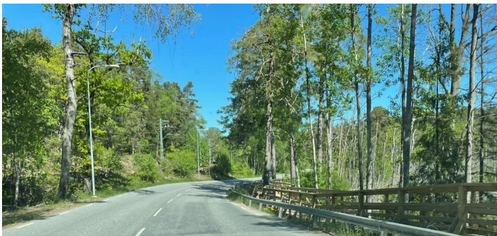
Figur 10 Gångbro i trä längs med Saltsjöbadsvägen, höger i bild.
