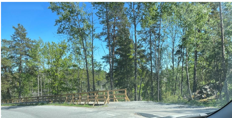
Figur 11 Gångbro i trä längs med Saltsjöbadsvägen som ansluter till separerad gångbana.
