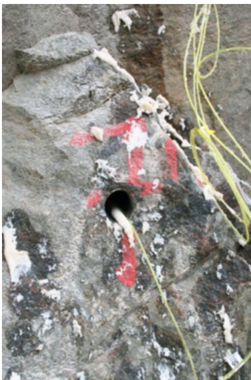
Figur 3 visar bild på ett laddat borrhål inför sprängning. Det vita som syns på berget är spill från sprängmedlet.
